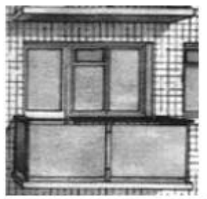
Балконные ограждения, выполненные из листов плоского шифера
